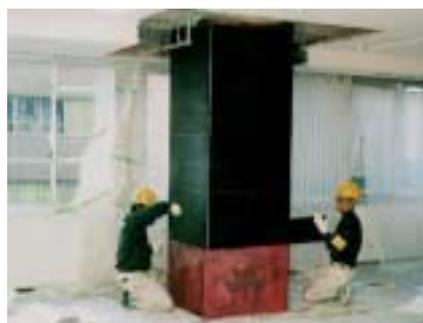
図3 ビルの柱の補強
