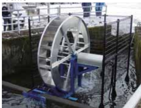
図17 水車据付状況
