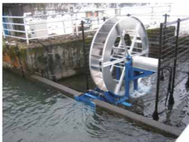
図5 実証試験設備全景
