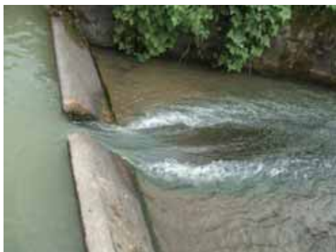
図15 喜多方市内開水路
