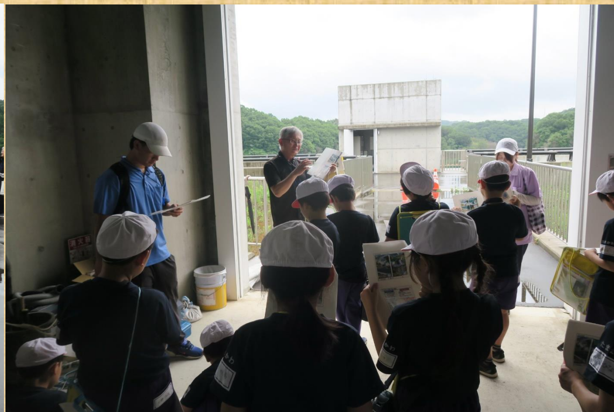
水位低下設備内の見学
