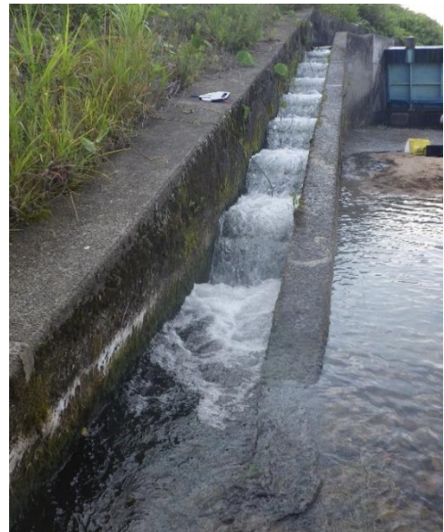
図 2 魚道の構造
