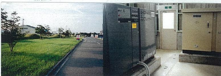
相馬工場には空気圧縮機、送風機及びディーゼルエンジン等の騒音・振動発生設備があります。これらの設備は振動・騒音の小さい設備を設置し、極力屋内に配置すると共に工場周辺に緩衝緑地を設けて遮音効果の向上を図っています。
