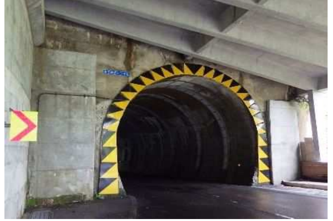
2 国道252号 田子倉沢隧道工区(只見町)【トンネル修繕】
