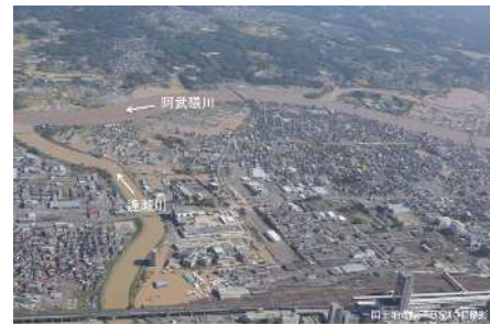
令和元年東日本台風の被災状況
