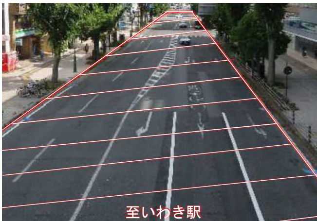
9 国道399号(いわき市)【自転車通行空間整備】
