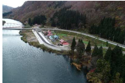
現況（湯倉地区）
