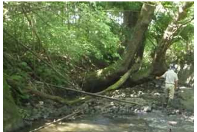
6 牛沢川(国見町)【溪流保全工】
