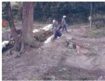
<土砂流出状況 (H16.7)>
