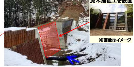
流木捕捉工を設置
