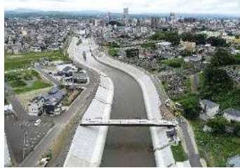
河川改修事業(一級河川逢瀬川)
