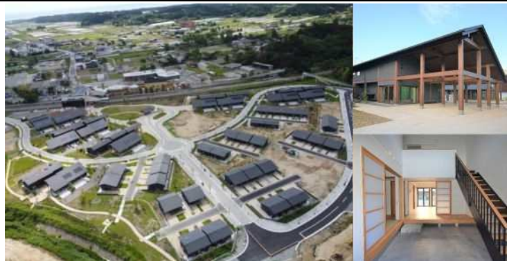
帰還者向け災害公営住宅等(双葉町駅西住宅)
