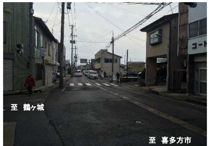
10 日新町徳久線(会津若松市)【道路改良】
