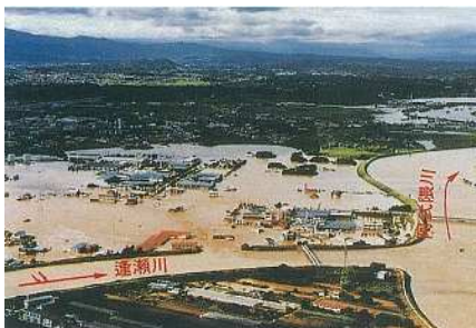
昭和61年8月の台風第15号の被災状況
