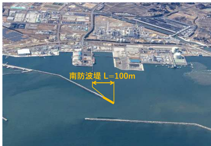
相馬港防波堤整備箇所
