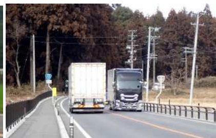
<整備後(道路拡幅)>
