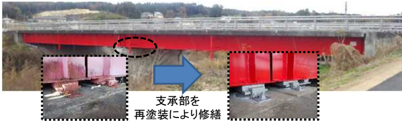
<全景 一般県道浪江鹿島線 北台木橋>
