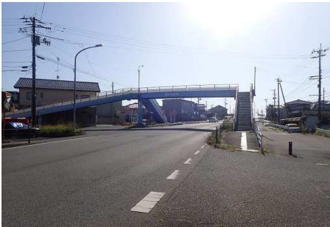
3 いわき上三坂小野線 金山歩道橋工区(いわき市)【道路附属物修繕】
