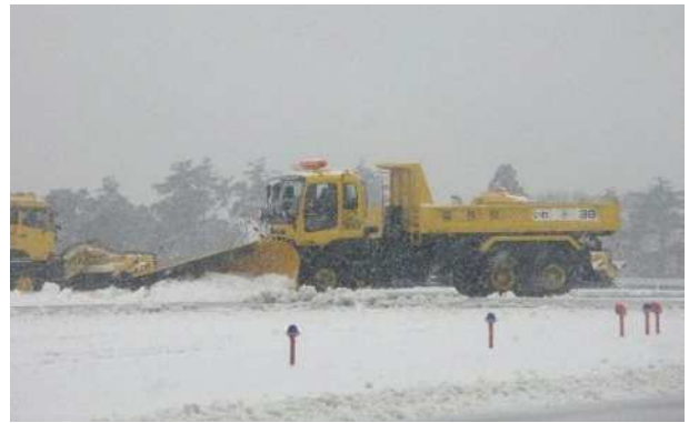
空港滑走路の除雪状況
