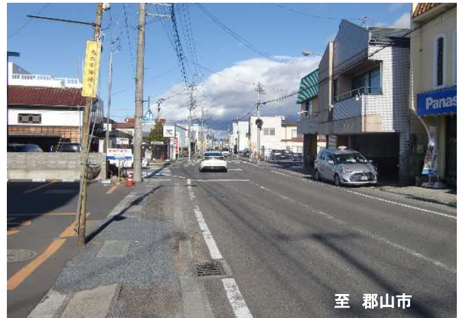
8 吹上荒町線(本宮市)【電線共同溝】
