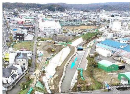
濁川 河川改修事業（整備状況）
