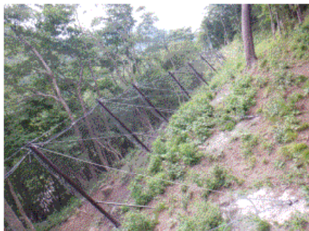
法面对策状況 (国) 118号<天栄村>
