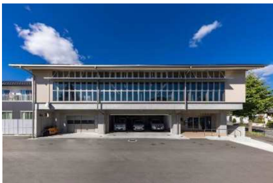
須賀川土木事務所(R2.3月竣工)
