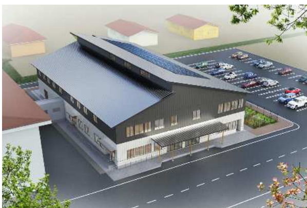
■南会津支援学校（南会津町） 【工事中、令和8年2月竣工予定】
