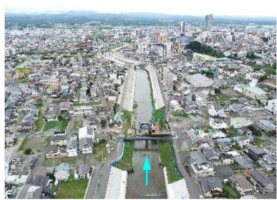
逢瀬川 河川改修事業（整備状況）
