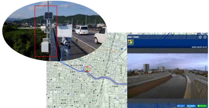
簡易型河川監視カメラ型の設置
