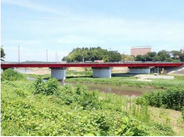
1 国道399号 平大橋工区(いわき市)【橋梁修繕】
