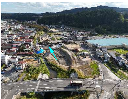
右支夏井川 河川改修事業（整備状況）
