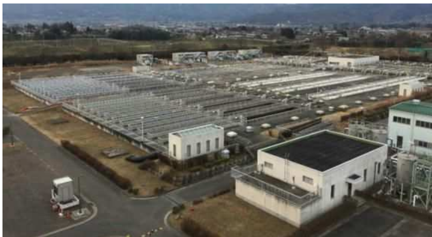
県北浄化センター
