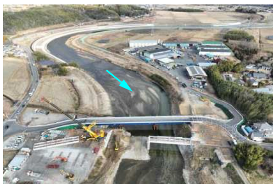
夏井川 河川改修事業（整備状況）
