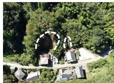
急傾斜地の崩壊／山ノ神地区（いわき市）
