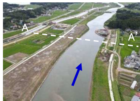
樹木伐採・河道掘削整備後 (令和4年7月撮影)
