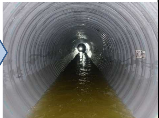
管更生により耐震性能を確保
