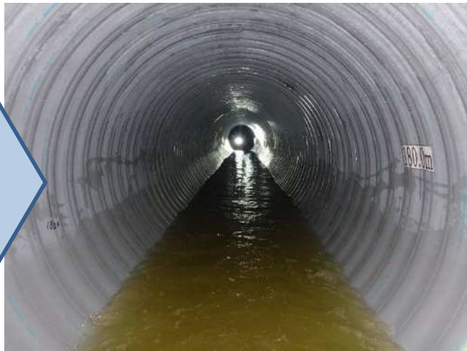
管更生により耐震性能を確保
