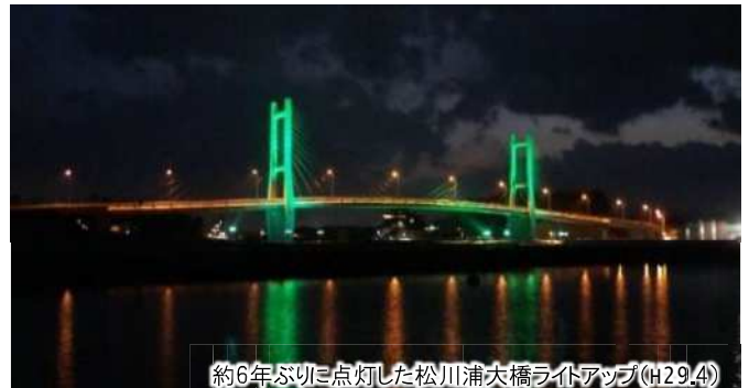
約6年ぶりに点灯した松川浦大橋ライトアップ(H29.4)
