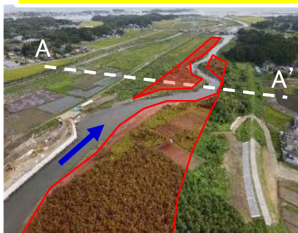
樹木伐採・河道掘削着手前 (令和2年9月撮影)
