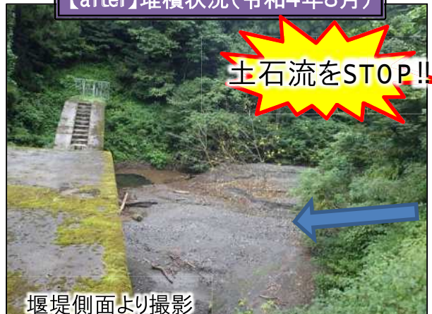
【after】堆積状況(令和4年8月)
