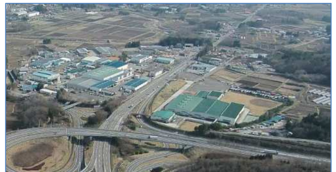
矢吹IC付近の工業団地(写真提供：矢吹町)
