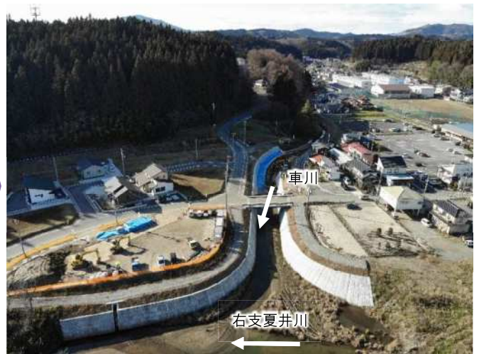
車川の合流付近の河川改修工事(令和4年3月)
