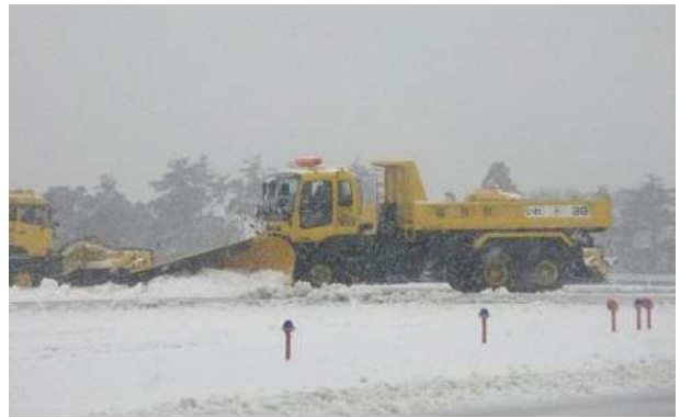
空港滑走路の除雪状況
