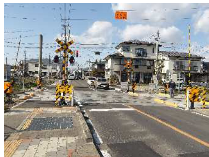
通学路の歩道整備 (主) 喜多方会津坂下線<喜多方市>
