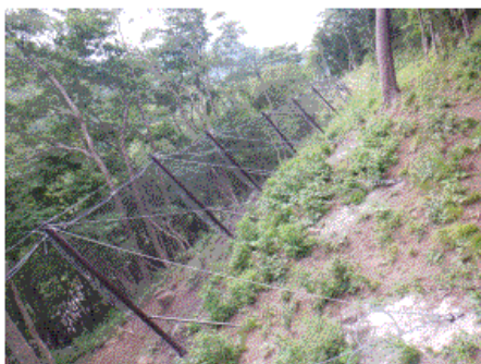
法面对策状況 (国) 118号<天栄村>
