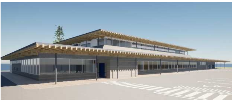
■須賀川支援学校（須賀川市）
