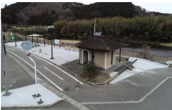
元気ふくしま地域づくり交流促進事業 休憩施設整備(矢祭町奥久慈地区)
