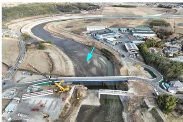
夏井川 河川改修事業（整備状況）
