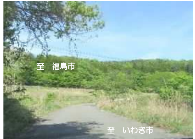
4 国道399号 滝下工区(飯館村)【道路改良】
