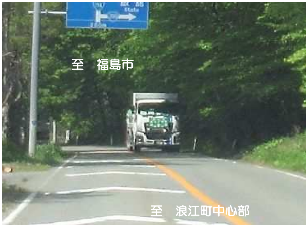
3 国道114号 津島1工区(浪江町)【道路改良】
