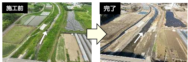
(河道掘削) 広瀬川(伊達市)
