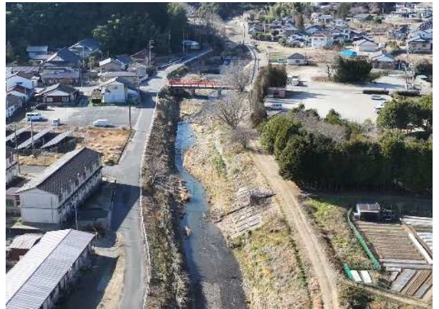
10 新川・宮川(いわき市)【河川改良】
