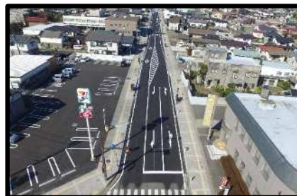
(都)中央線外1線(伊達市)の 無電柱化整備完了状況
