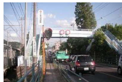
(都)栄町大笹生線(福島市) 【防災・安全交付金事業】 県道 福島飯坂線において、現道拡幅を実施
