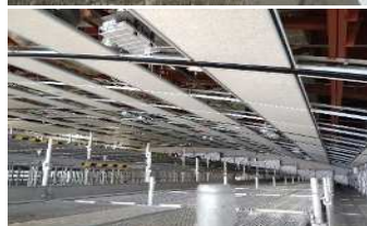
体育館(天井)の耐震改修
