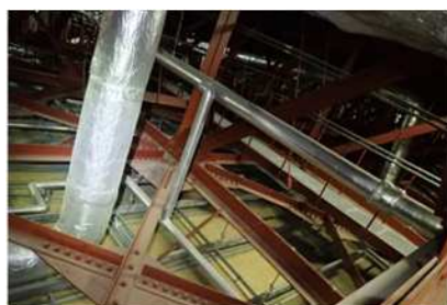
あづま総合運動公園(福島市) 【減災化事業】 あづま総合体育館メインアリーナにおいて、天井吊り部材更新を実施
