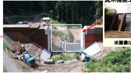
流木捕捉工を設置
