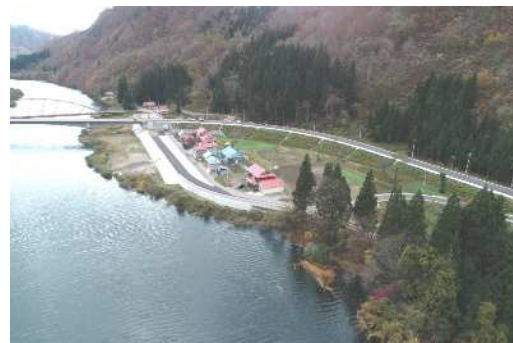
現況（湯倉地区）
