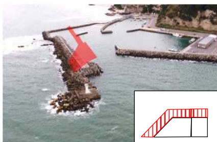
豊間漁港(いわき市)【漁港事業】 防波堤改良工を実施
