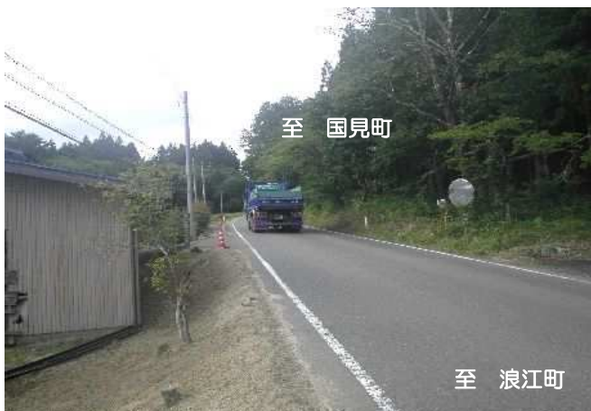
5 浪江国見線 佐須4工区(飯館村)【道路改良】
