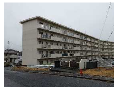
湯長谷団地2号棟(いわき市) 【県営住宅改善事業】 老朽化した外壁等について改修工事を実施
