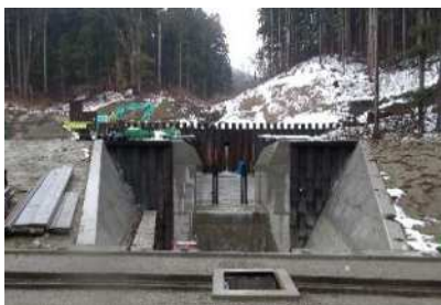
院内沢(会津若松市)【砂防事業】 砂防堰堤工を実施
