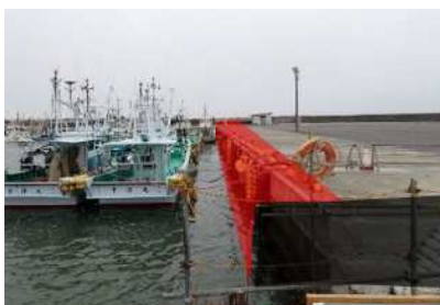
請戸漁港(浪江町)【漁港事業】 岸壁改良工を実施
