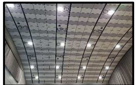
あづま総合運動公園(福島市)の 天井灯具LED化・パネル更新状況
