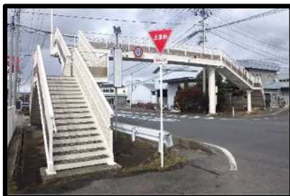
国道288号 原歩道橋(郡山市)
