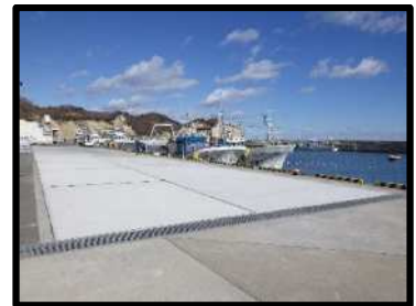
久之浜漁港 岸壁耐震化(いわき市)
