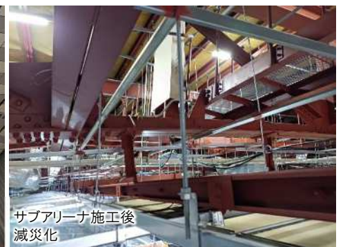
サブアリーナ施工後
