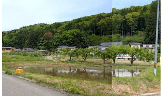
8 安養寺(福島市)【擁壁工】
