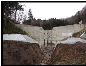
西田面沢 砂防事業(会津若松市)
