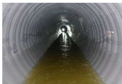
県中幹線(郡山市)【改築事業】 老朽化した下水道管路について、管更生工法による改築を実施 左岸幹線(福島市)【耐震化事業】 耐震化されていない下水道管路について、管更生工法による耐震化を実施
