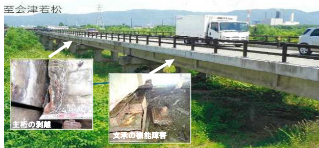
<全景 県道会津若松三島線 蟹川橋>
