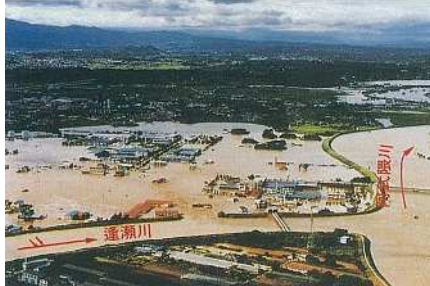
昭和 61 年 8 月の台風第 15 号の被災状況
