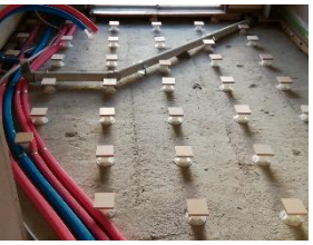
②③⑤浴室・洗面所・台所へ給湯配管設置
