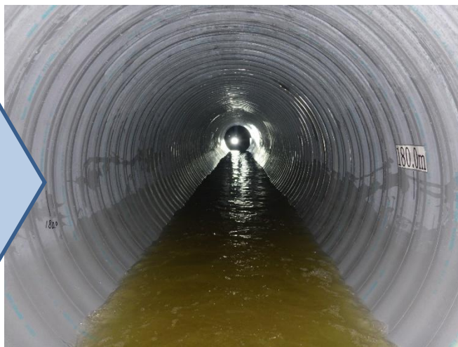
管更生により耐震性能を確保
