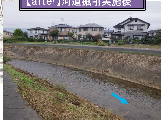
【after】河道掘削実施後
