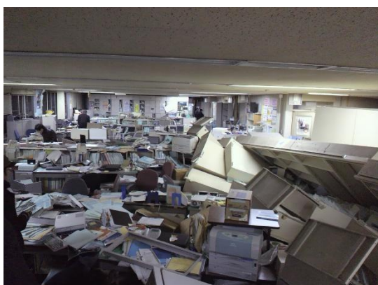
写真3 地震による県庁舎内の被災状況
