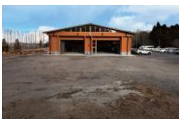
● 実習スペース
