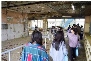
震災遺構浪江町立請戸小学校
