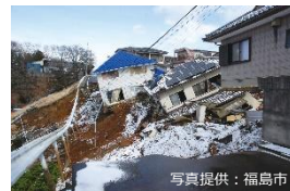
家屋被害：福島市
