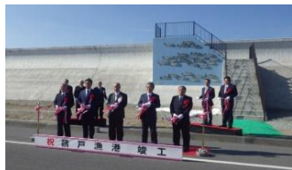
請戸漁港 2021年11月20日竣工式 県内被災10漁港復旧完了
