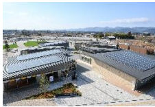
大熊町：商業施設
