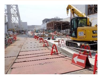
フェーシング前 (3号機付近)
