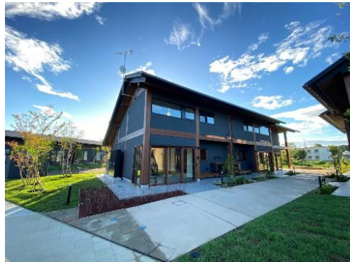
双葉町：駅西住宅
