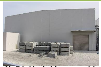
固体廃棄物貯蔵庫第10-C棟の外観 (出典：東京電力ホールディングス)
