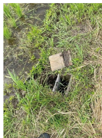
排水調整器具の状況
