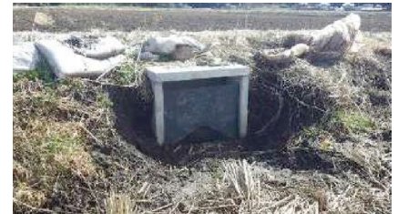
排水マス (全景) ※撮影した休耕期では排水調整板を逆さまにして設置
