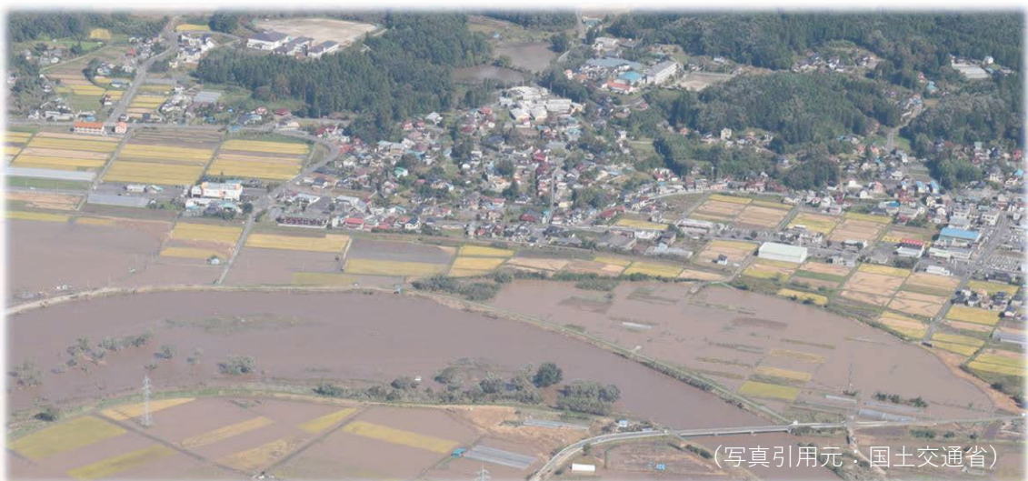
■大雨により氾濫する阿武隈川の様子（令和元年10月撮影）
