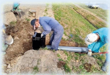
排水口の整備
