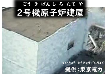
ごうき 1号機 1号機の爆発の衝撃で開いた パネルから水素が外に排出さ れたため、爆発しなかった。
