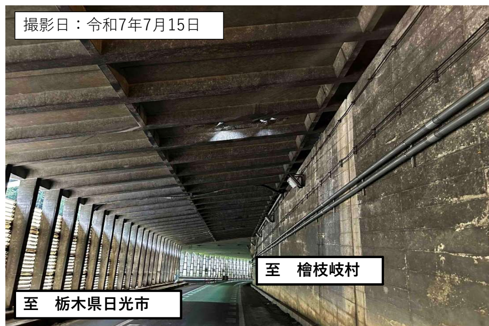
スノーシェッド内は1車線の下り専用通行区間
