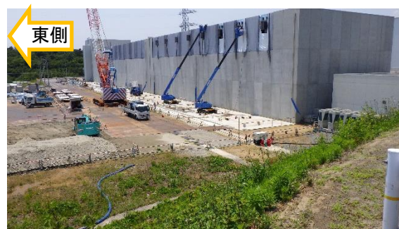
(写真 1－2) 保管庫外観（北側） （令和 7 年 6 月 2 日撮影）
