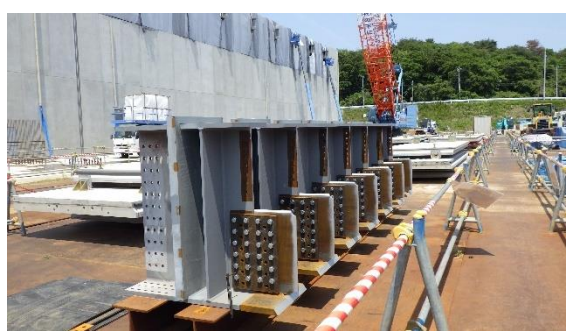
(写真 3-2) 取り付け前の鉄骨ブラケット
