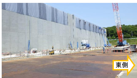
(写真 1－1) 保管庫外観（南側） （令和 7 年 6 月 2 日撮影）
