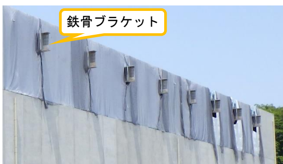
(写真 3-1) 鉄骨ブラケット取り付けの状況
