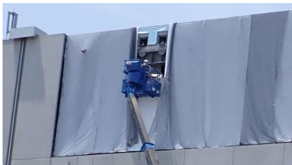
(写真 2-1) 鉄骨ブラケット取り付け作業の状況
