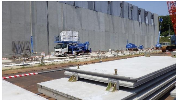
(写真 2-2) 取り外された外壁
