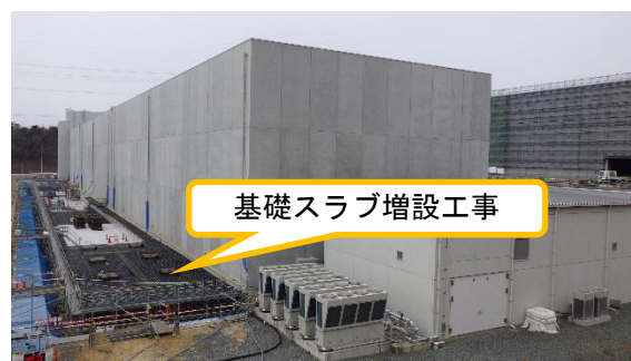
(写真 1－4) 保管庫外観（北側） （令和 7 年 1 月 2 1 日撮影）
