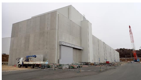
(写真 1－3) 保管庫外観（南側） （令和 7 年 1 月 2 1 日撮影）
