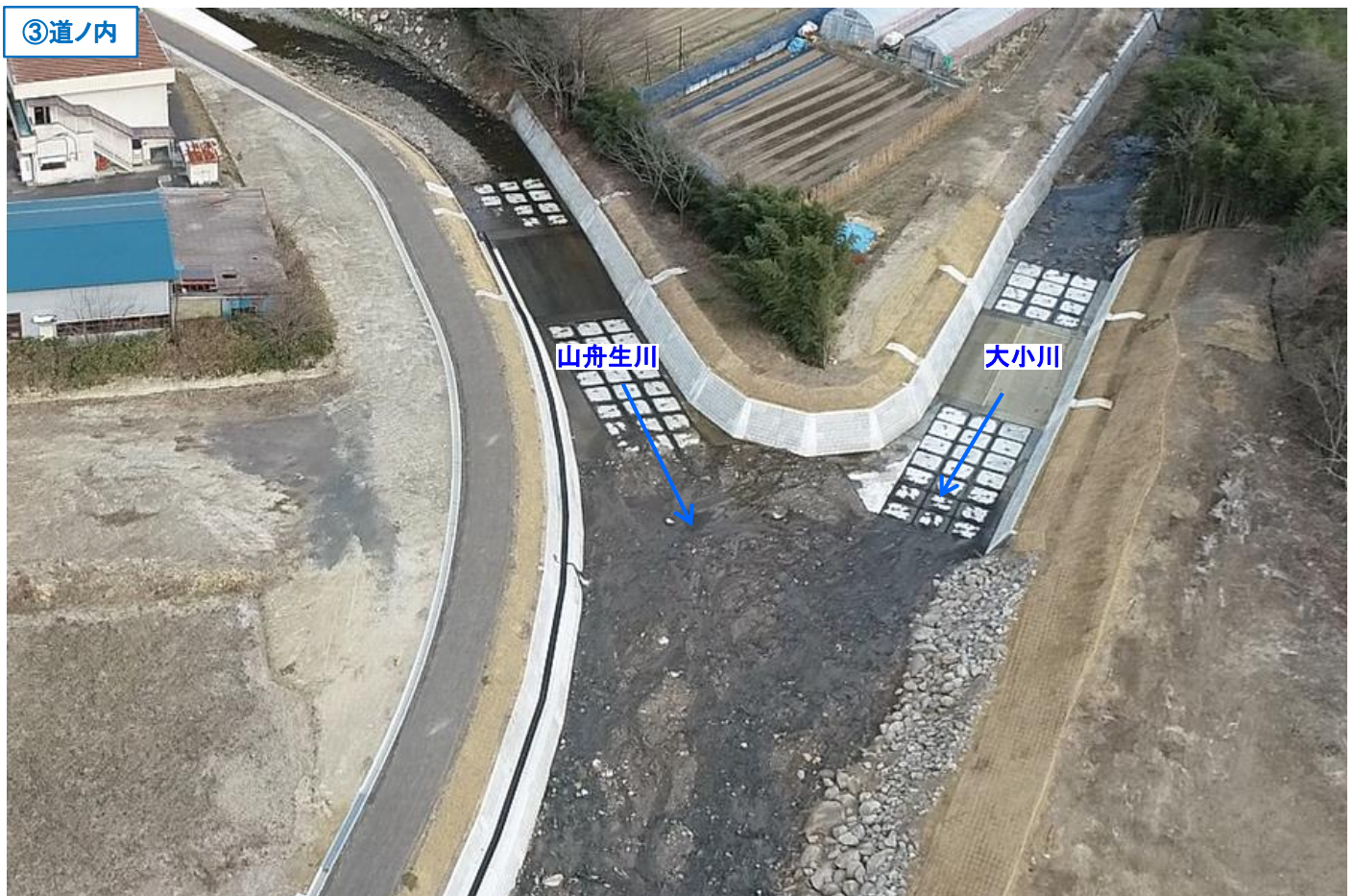
工事完了後(R7.3.14)
