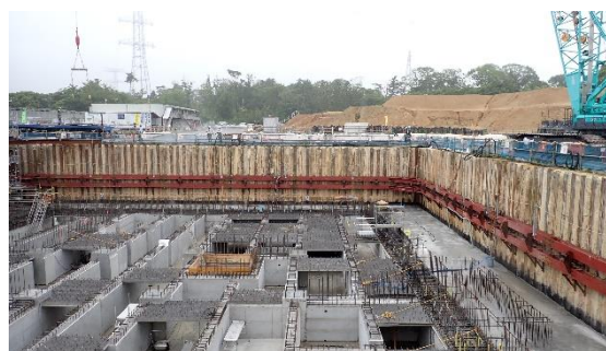
（写真1②）JAEA第2棟建設状況
