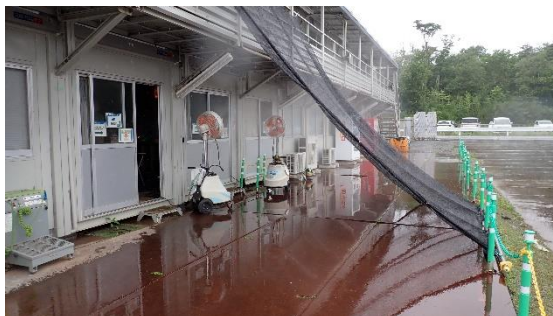
(写真 3 ③) 現場事務所出入口に設置されたミスト扇風機
