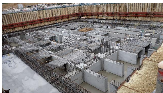
（写真1①）JAEA第2棟建設状況
