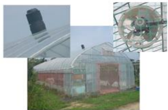
写真5：空動扇（左）、防虫ネット（中）、換気扇（右）
