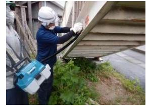
原歩道橋 点検状況
