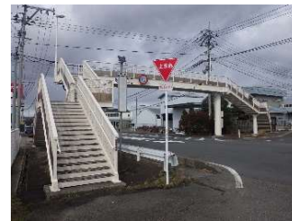
原歩道橋 橋梁補修完了
