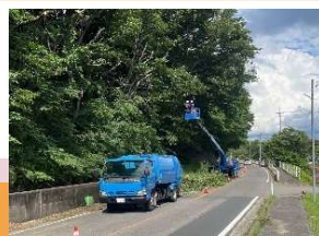
道路支障木伐採
