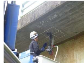
舟津橋 点検状況
