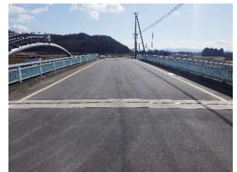
新橋 橋梁補修完了
