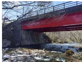
坂口橋 橋梁補修完了
