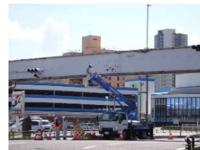
わかば歩道橋 点検状況
