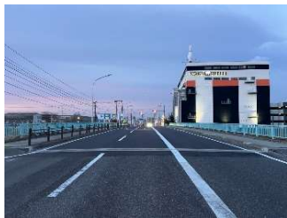
逢瀬川橋 橋梁補修完了
