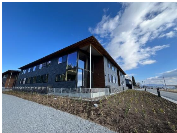
学生寮 A 外観(南面)
