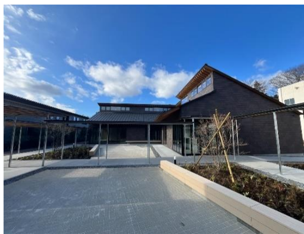
学生寮 D 外観(北面)
