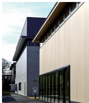
校舎 外観(南面)
