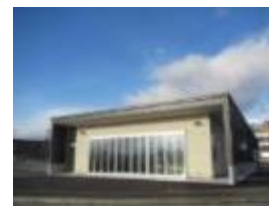
猪苗代水環境センター
