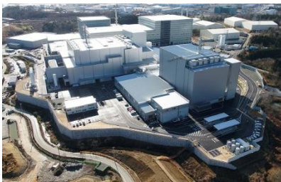
仮設減容化施設
