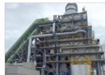
仮設焼却施設
