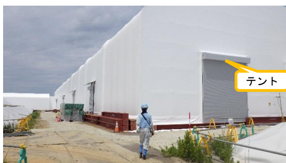
(写真 1－1) 第 4 槽の状況
