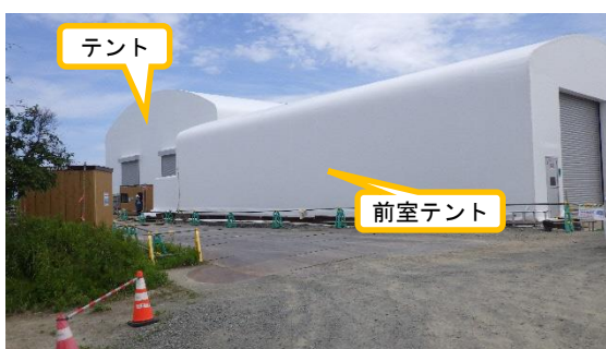
(写真 1－2) 前室テントの状況
