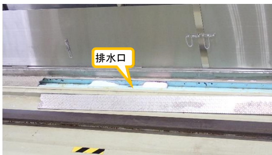
(写真 2－2) 排水口周辺の状況
