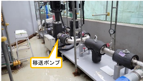
(写真 1－3) J 1－E 6 タンク 払出し 弁からの 移送実施状況③ (J 1－E 群タンク内堰内に新設 された移送ポンプ)
