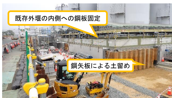
（写真4） K4タンクエリア南西部の拡張外堰 におけるコンクリート打設工事の状 況
