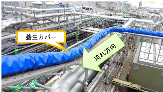
(写真 2－1) 移送ルート の 状況① (移送ホースに養生カバーを設置)
