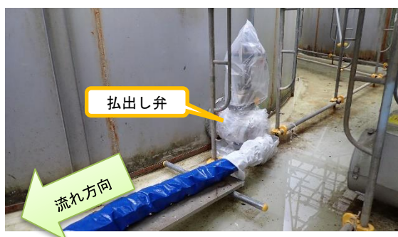
(写真 1－1) J1－E6タンク払出し弁からの 移送実施状況①
