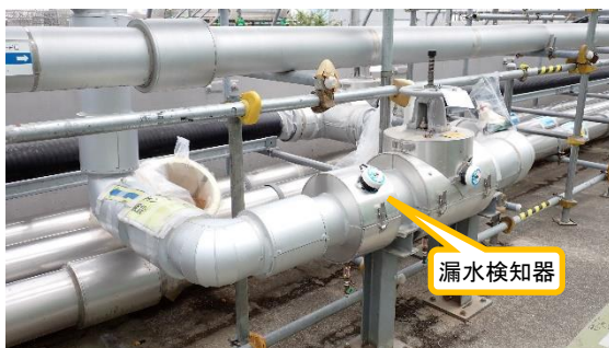
(写真 2－2) 移送ルート の 状況② (移送ルート 要所 には、漏水検知器 を設置)
