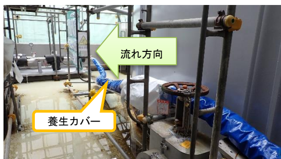
(写真 1－2) J1－E6タンク払出し弁からの 移送実施状況② (払出し弁から移送ポンプへ)
