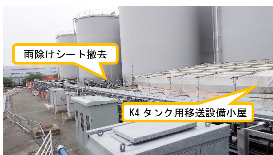
（写真5） K4タンクエリア北東部の既存外堰 の嵩上げ工事に向けた準備状況 （雨除け用の天蓋を撤去済み）
