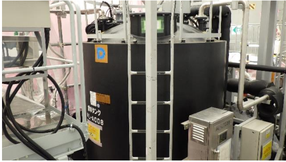
(写真 2 - 2) 排水タンクの設置状況
