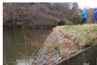
▲鞍掛池点検の様子
