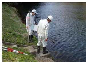
▲長沼池点検の様子
