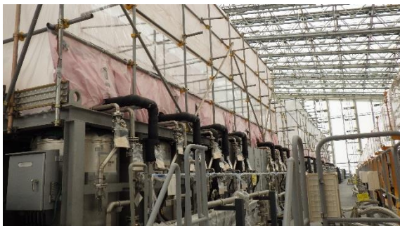
(写真 1) 吸着塔上部の養生
