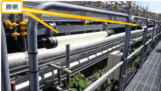
(写真 3) 照明の設置状況
