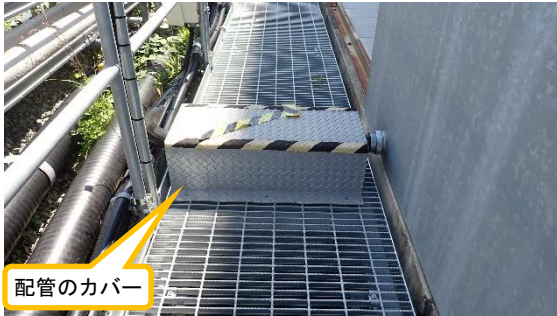
(写真 2 ①) カバーの設置状況
