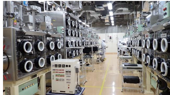
(写真 4) 瓦礫類の前処理作業の状況
