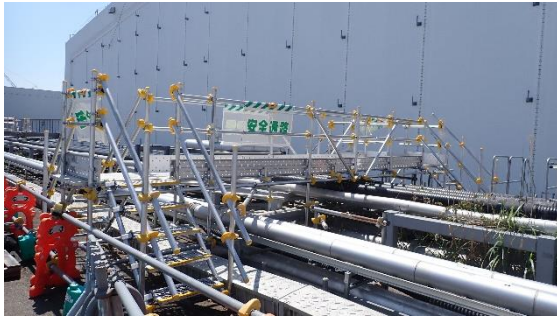
(写真 1 ①) 歩廊への誘導路
