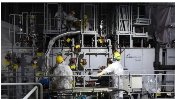
(写真 1) 吸着材抜き出し作業の状況
