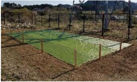
図7 施工後のCT織物防草シート(三種類)
