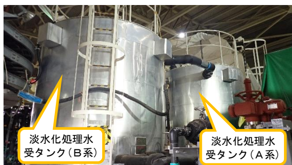
(写真1-3) 淡水化処理水受タンクの設置状況
