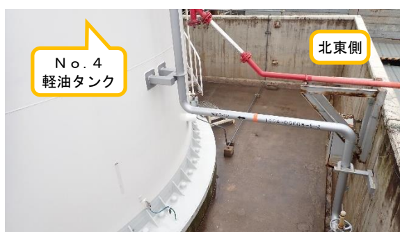
(写真 2－2) N o . 4 軽油タンク北東側の防油堤内の状況（水溜まりなし）
