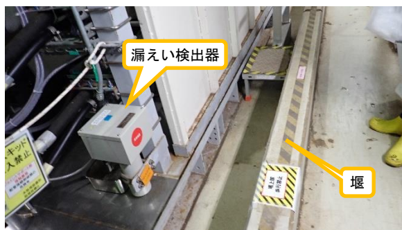
(写真 1－5) 漏えい検出器及び堰による漏えい対策の状況
