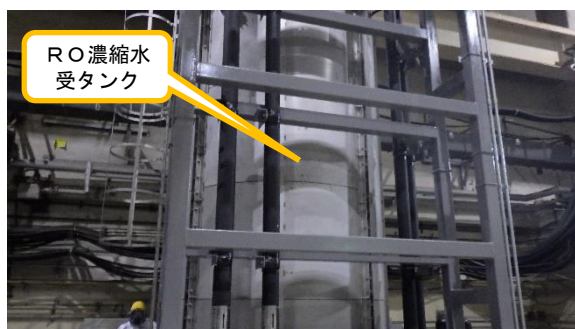
(写真1-4) RO濃縮水受タンクの設置状況
