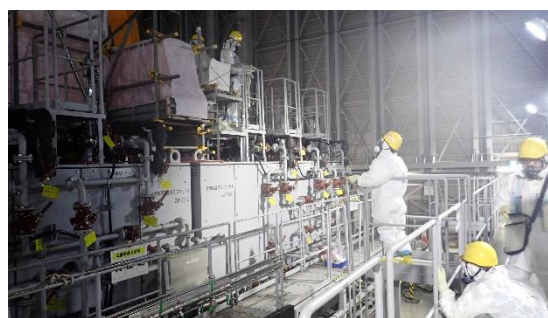
(写真 1 ②) 吸着材交換作業の状況
