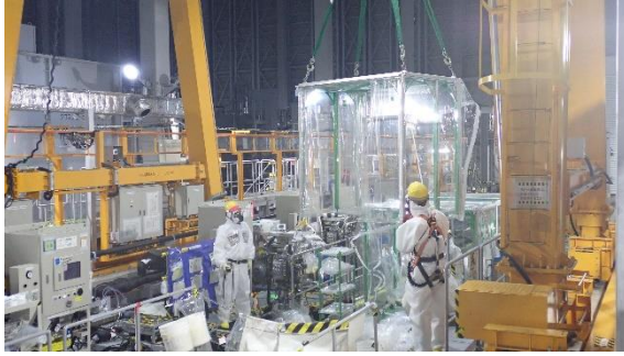
(写真2③)ビニールハウスの吊り上げ
