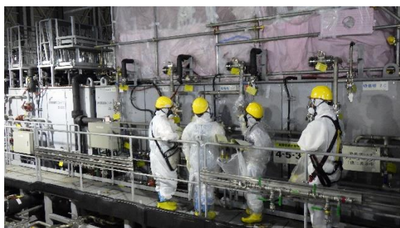
(写真 1 ①) 吸着材交換作業の状況
