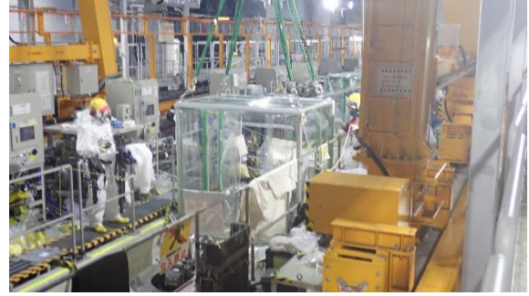
(写真2④) ビニールハウスの移設・据付
