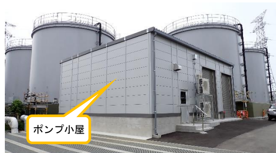
(写真 4) タンク群東側の状況
