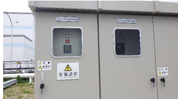
(写真 8) 高圧配電盤の設置状況
