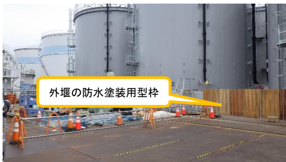
(写真 3) タンク群西側の状況
