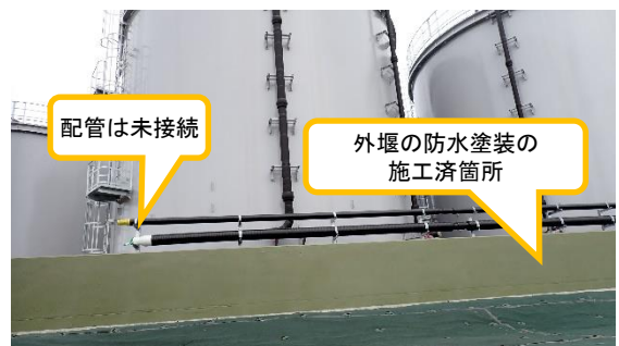
(写真 6) 配管敷設状況（未接続）
