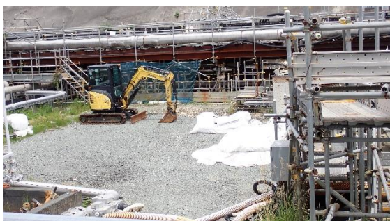
(写真 1) No. 1 重油タンク跡地の状況
