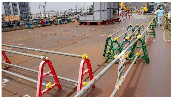
(写真 2 - 1) No. 1 重油タンク解体物保管エリアの 状況①
