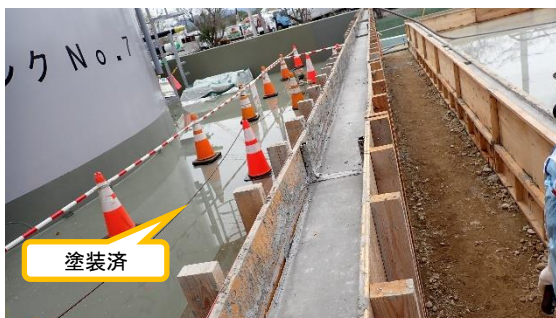
(写真 5) 外堰の防水塗装状況
