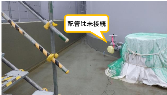
(写真 7) 配管の接続状況（未接続）
