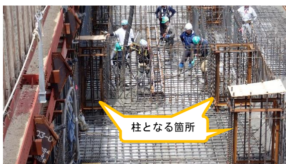
(写真 4－2) コンクリート打設工事の状況
