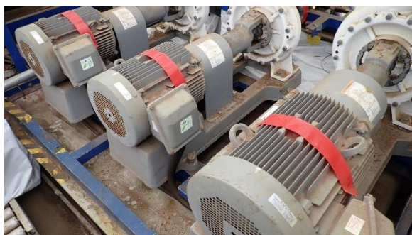
(写真 2－2) 高圧ポンプ取替工事の状況② ※取替前の高圧ポンプ
