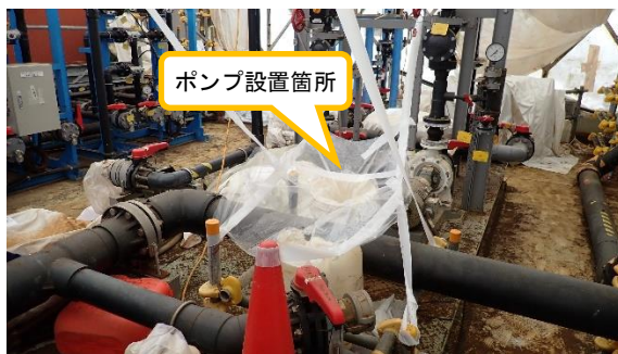
(写真 2－1) 高圧ポンプ取替工事の状況① ※ポンプが取り外された状態
