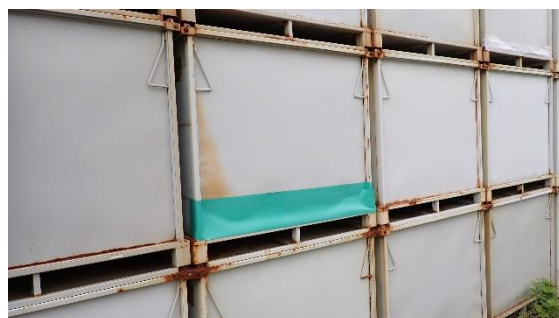
(写真3①) コンテナの補修状況
