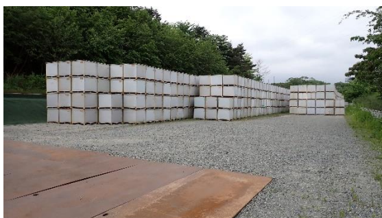
(写真1) 瓦礫類一時保管エリアIの状況
