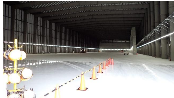
(写真5①) 第10-C棟内での作業状況
