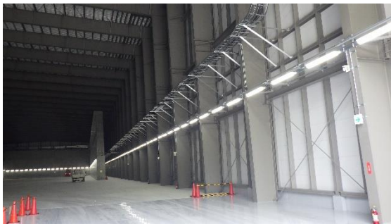
(写真5②) 第10-C棟内での作業状況
