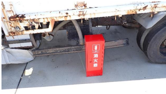
(写真 4—2) 使用禁止車両付近の消火器設置の状況
