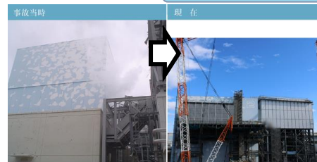
2024/10- 燃料取出し設備設置の準備工事開始
