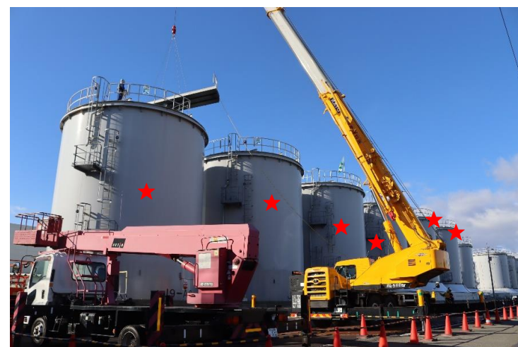
タンク上部（天蓋）を撤去する様子 ※2025年5月29日時点で、★の6基を解体済み。
