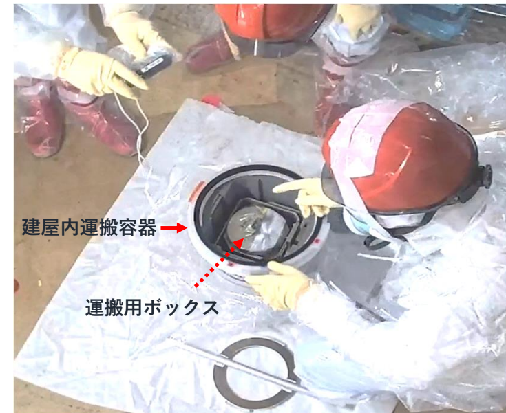
「運搬用ボックス」を「建屋内運搬容器」へ収納する様子
