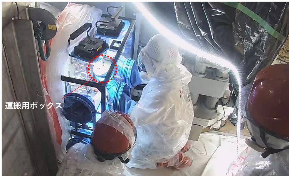
エンクロージャ側面ハッチから「運搬用ボックス」を取り出す様子
