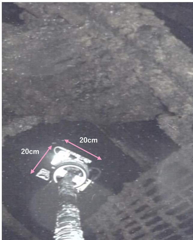
「開口2」上部の状況
