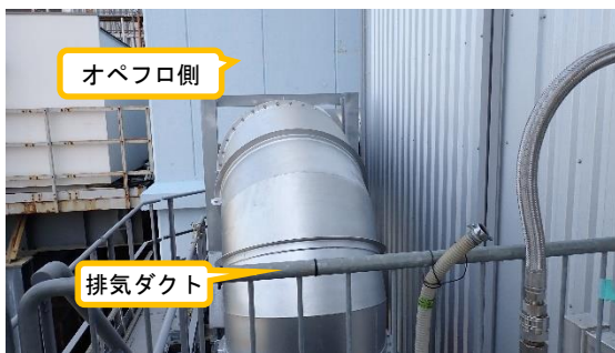
(写真 5) 排気ダクトの設置状況
