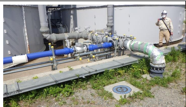
浸出水を移送する配管の状況 異常なし
