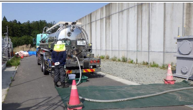
他工区からの浸出水の移送の状況（タンクローリー車による運搬） 異常なし
