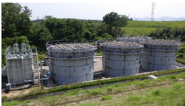
調整槽の状況 異常なし
