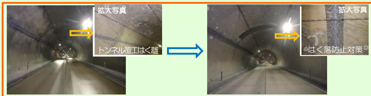
国道401号 喰丸トンネル（昭和村）
