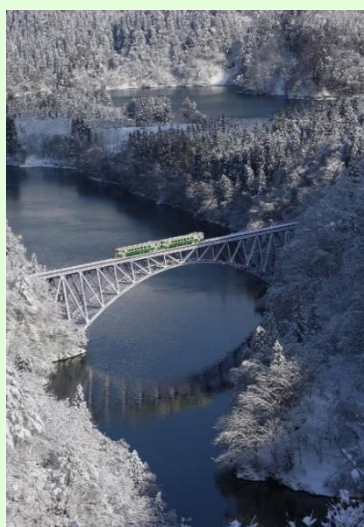
第1只見川橋梁
