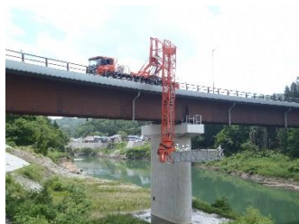
①橋梁点検を定期的に実施
