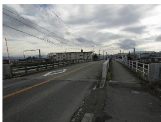
②補修箇所の確認
