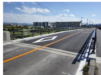
③補修施工を行い完了
