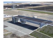
インフラ点検・災害対応エリア
