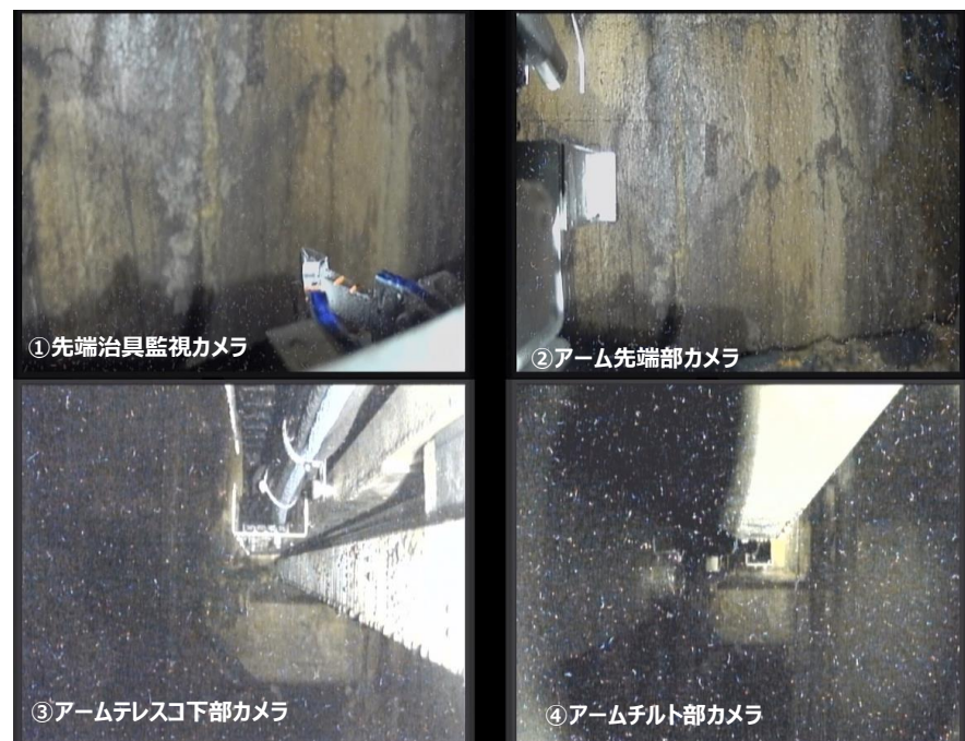
ペDESTAL壁面付近まで挿入した状況
