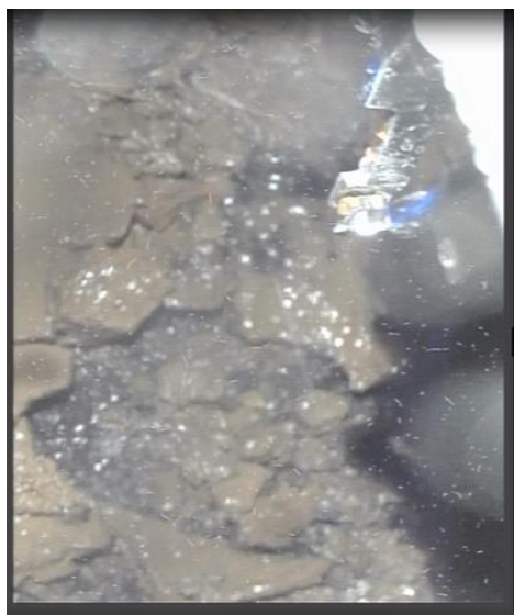
⑤先端治具吊上げ
