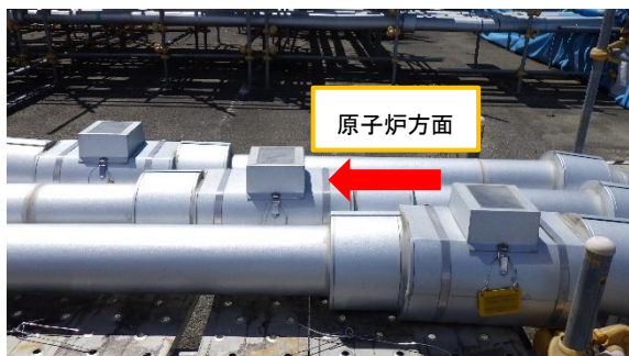
(写真 3 - 1) 常用高台炉注水ポンプにおける配管 の敷設状況①
