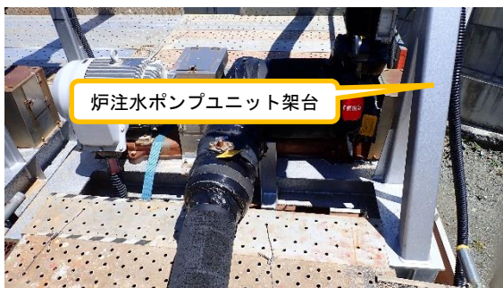
(写真 6－1) 炉注水ポンプユニット架台の設置状況①（令和 5 年 5 月 11 日撮影）
