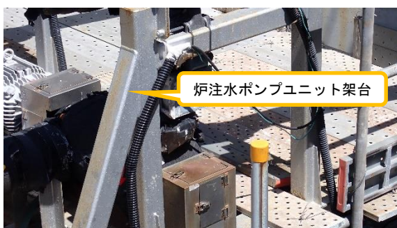
(写真 6－2) 炉注水ポンプユニット架台の設置状況②（令和 7 年 4 月 30 日撮影）
