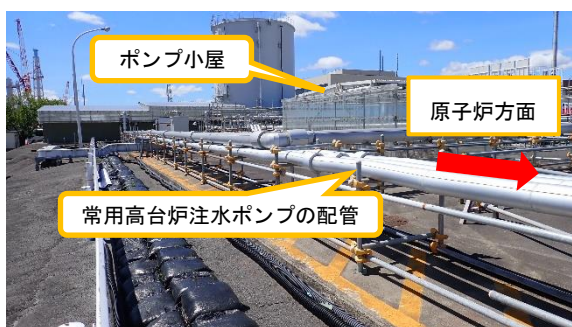
(写真 3 - 2) 常用高台炉注水ポンプにおける配管 の敷設状況②
