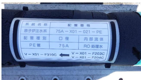
(写真 3 - 3) 常用高台炉注水ポンプにおける配管 の敷設状況③
