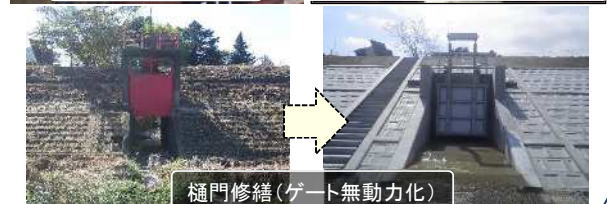
樋門修繕(ゲート無動力化)
