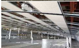
体育館(天井)の耐震改修
