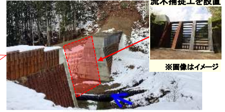
流木捕捉工を設置
