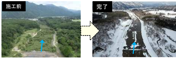
(河道掘削) 加藤谷川(下郷町)
