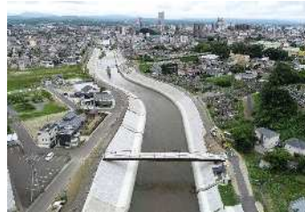
河川改修事業(一級河川逢瀬川)
